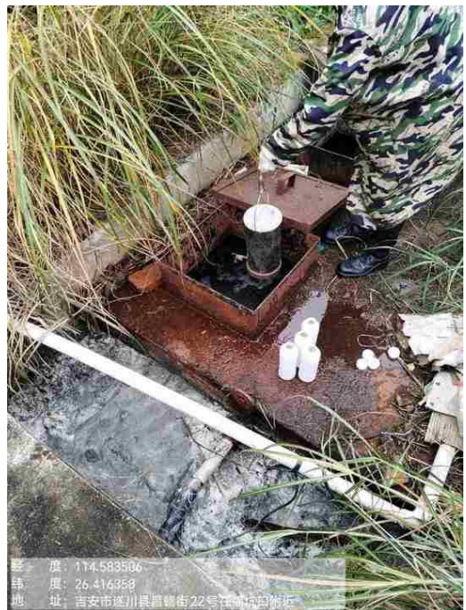
综合废水处理设施出口
